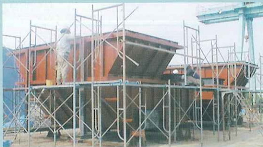
脱硝反応塔
